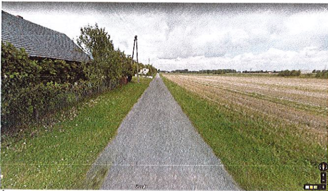
Fot. 1. Droga wewnętrzna gminna na dz. na 248 k.m.2 w m. Krasków – widok drogi na wysokości frontu dz. nr 229/63 (po lewej) w kierunku północnym
