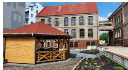
Budowa eko-klasy do zajęć dydaktycznych na powietrzu
