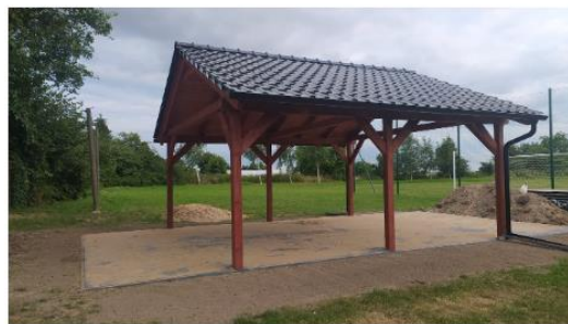
Budowa wiaty przy świetlicy w Krzywiźnie
