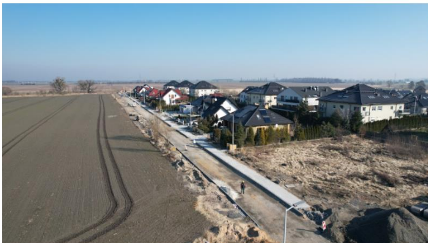
Budowa ul. Kantora i ul. Podkowińskiego w Kluczborku
