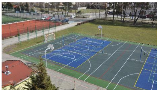
Budowa nawierzchni sportowo-modułowej wraz z wyposażeniem przy PSP nr 2 w Kluczborku
