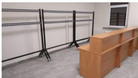
Modernizacja sali wiejskiej w Kraskowie
