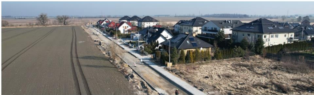
Budowa ul. Kantora i Podkowińskiego
