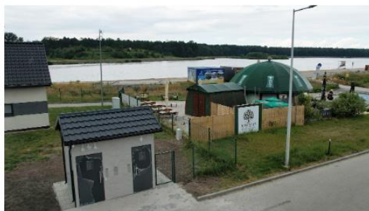
Budowa publicznej toalety przy zbiorniku retencyjnym KLUCZBORK w Ligocie Górnej
