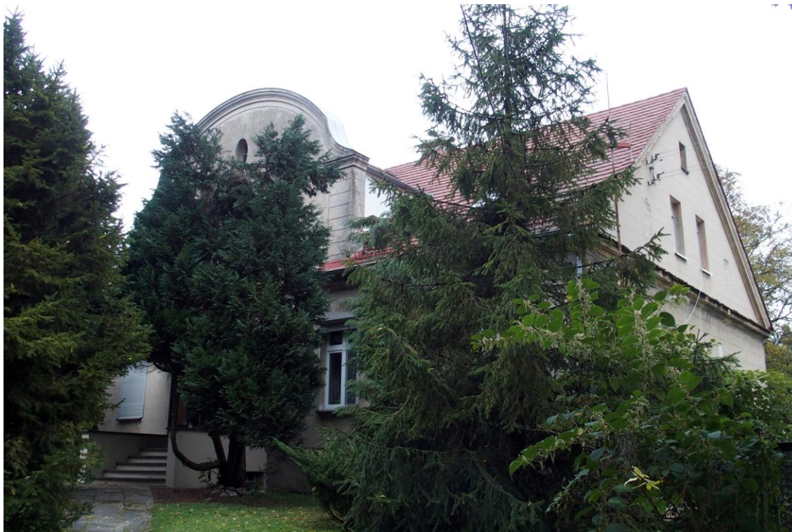
Widok budynku od południowego - zachodu
