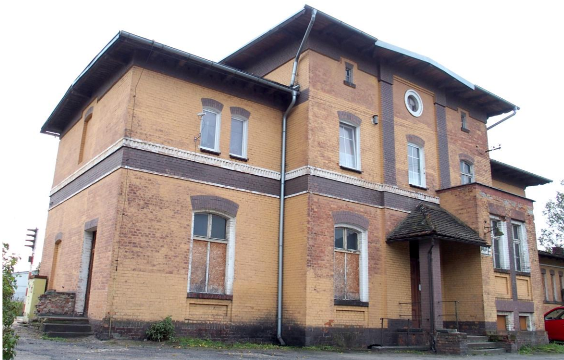
Widok budynku od północy
