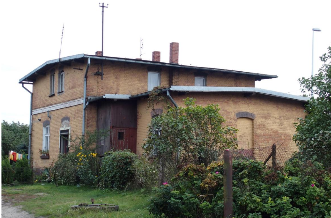
Widok budynku od północnego - zachodu
