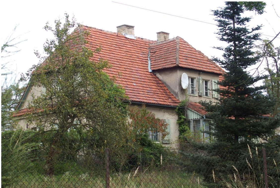
Widok budynku od południowego - zachodu
