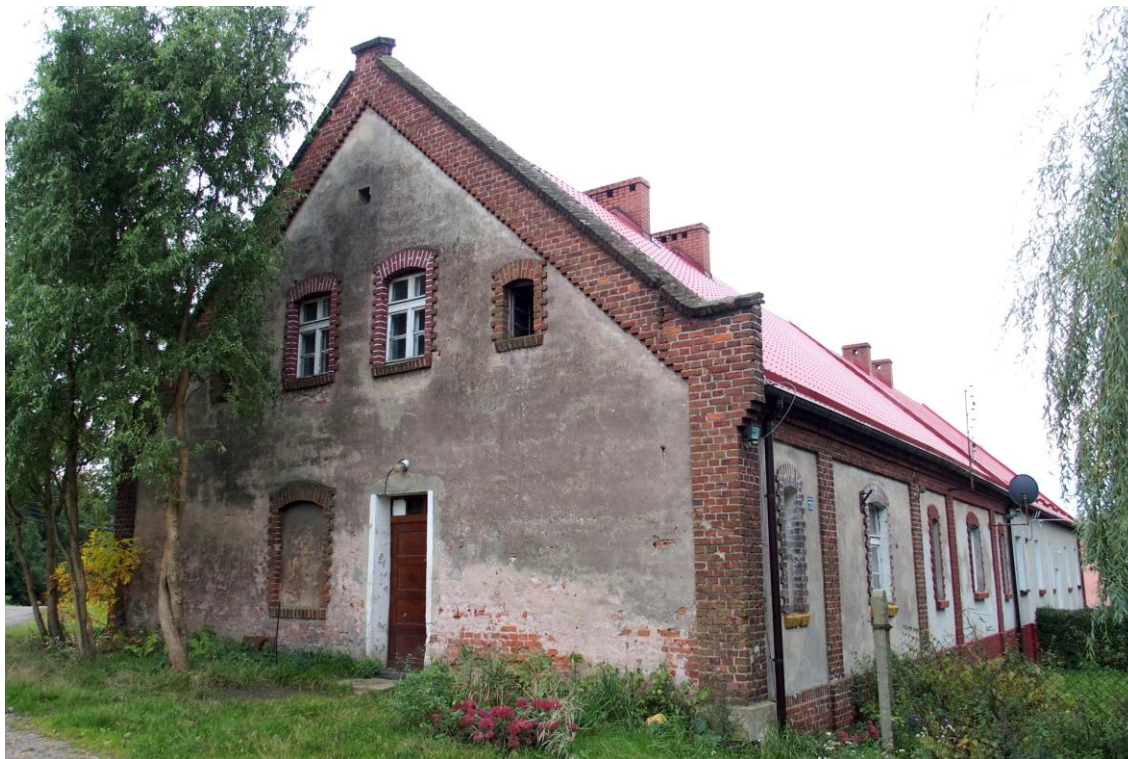
Widok budynku od północy
