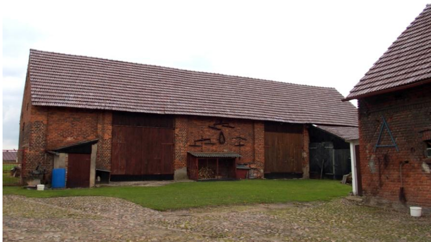
Widok budynku od południowego - zachodu
