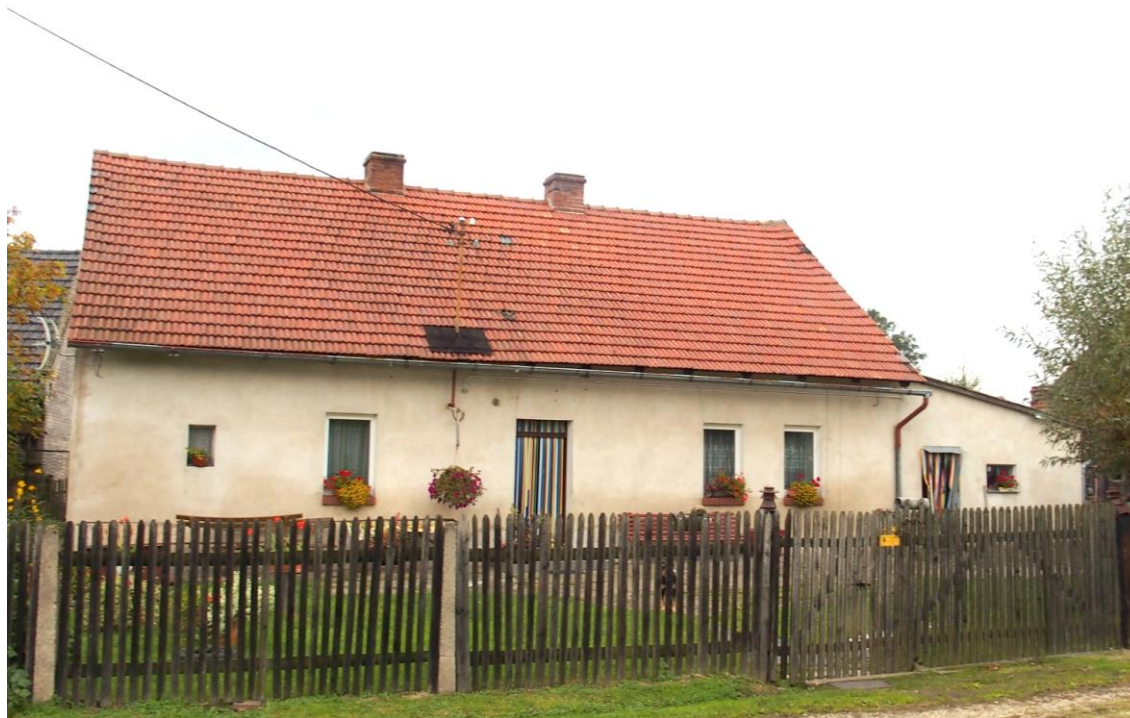
Widok budynku od wschodu
