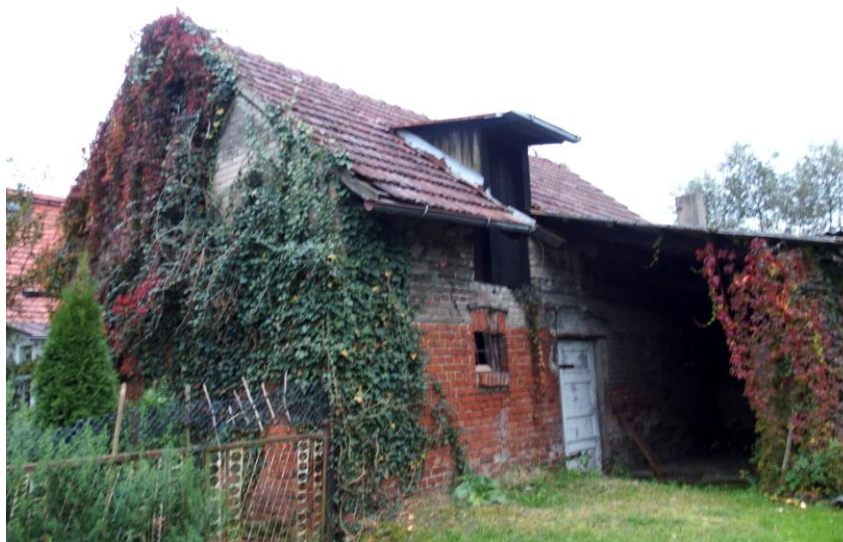
Widok budynku od północnego - wschodu
