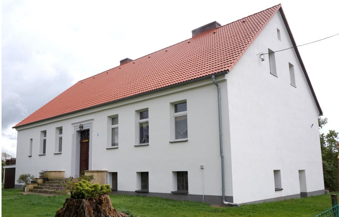
Widok budynku od północnego - zachodu
