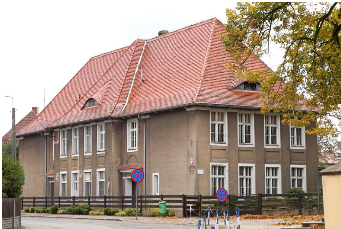
Widok budynku od północy
