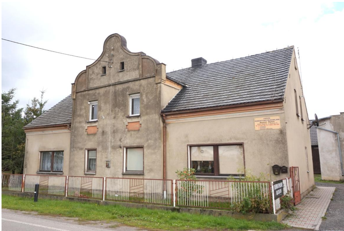
Widok budynku od południowego - zachodu
