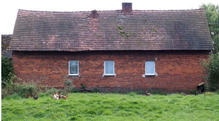
Widok budynku od północy
