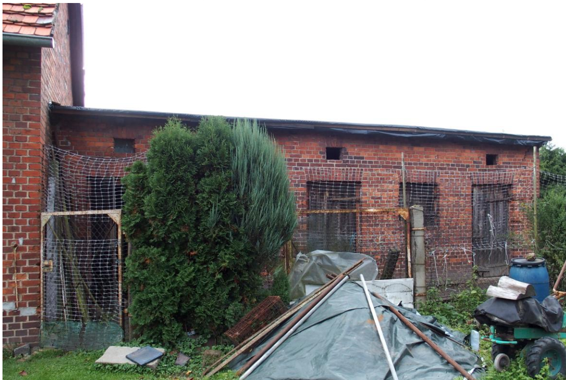
Widok budynku od wschodu
