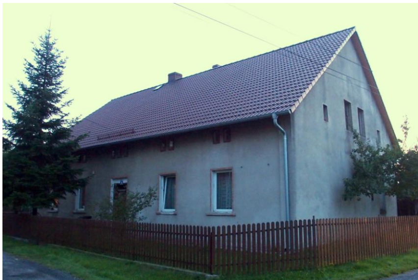
Widok budynku od północnego - wschodu
