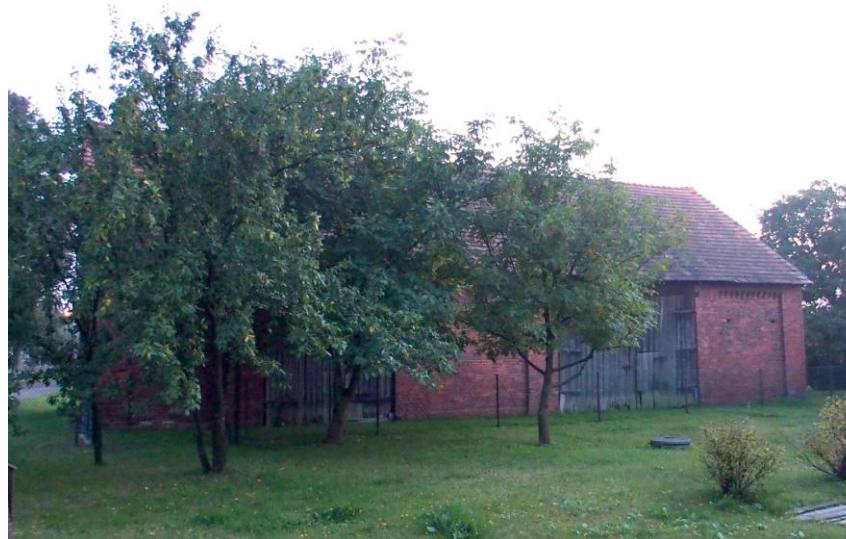
Widok budynku od północy
