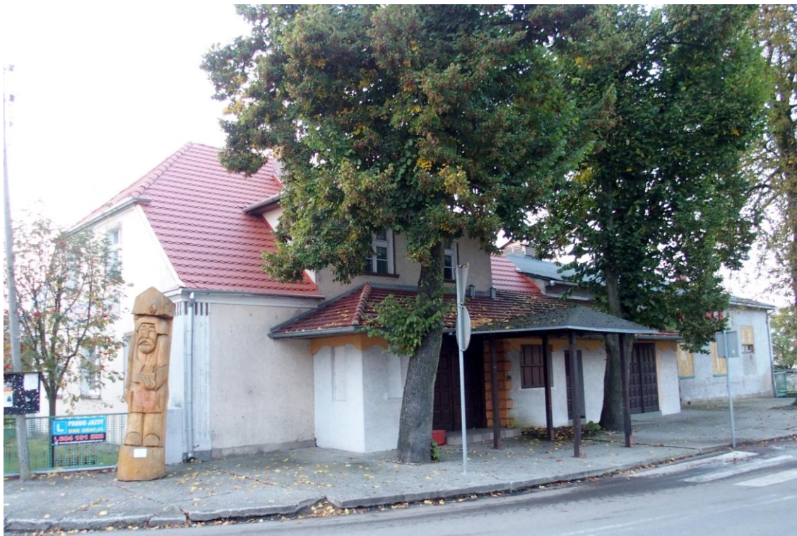
Widok budynku od północnego - zachodu
