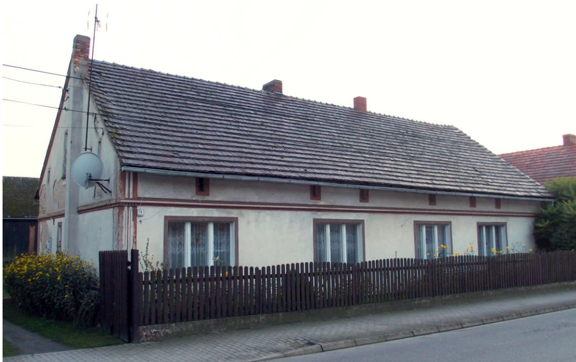
Widok budynku od północnego - wschodu
