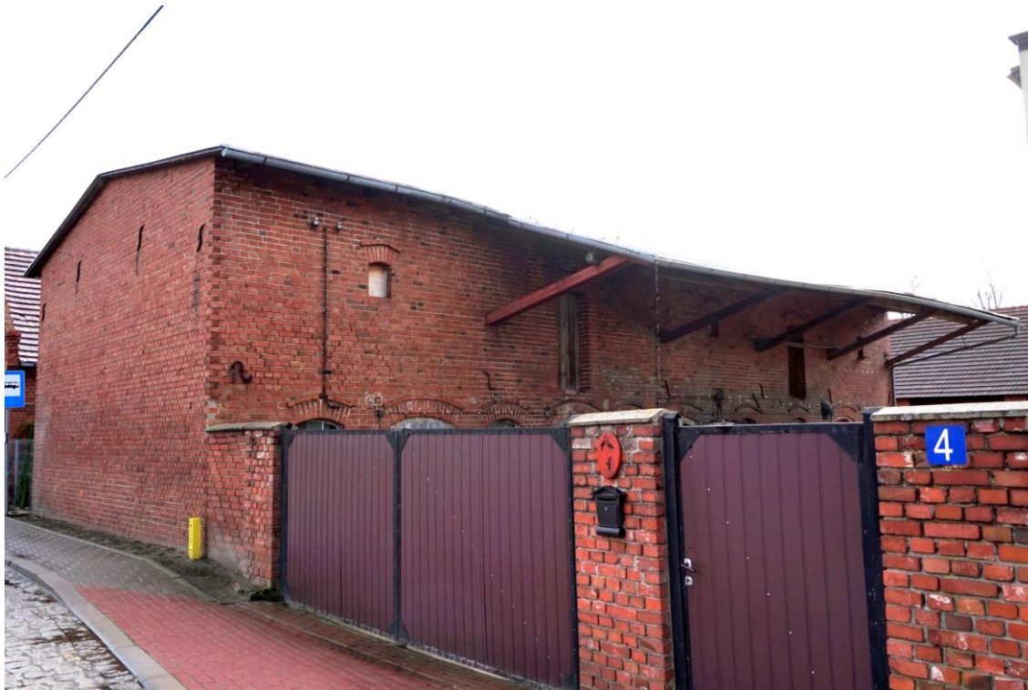
Widok budynku od północnego - zachodu
