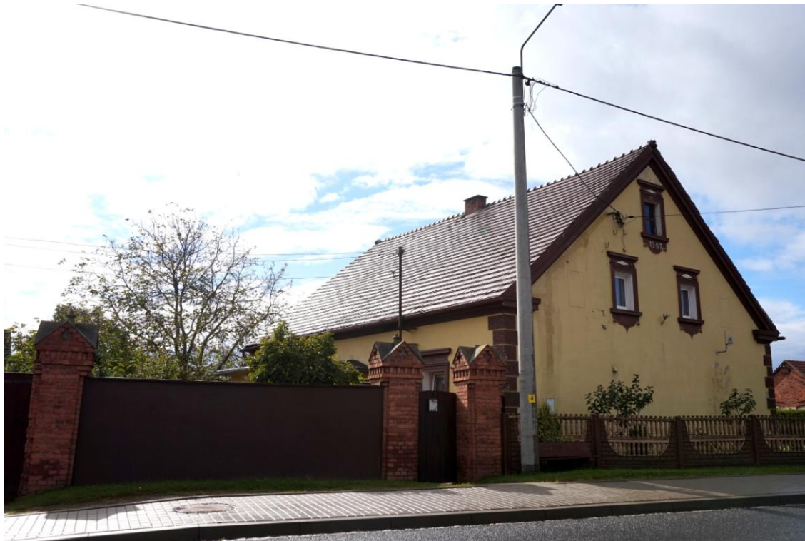
Widok budynku od północnego - wschodu
