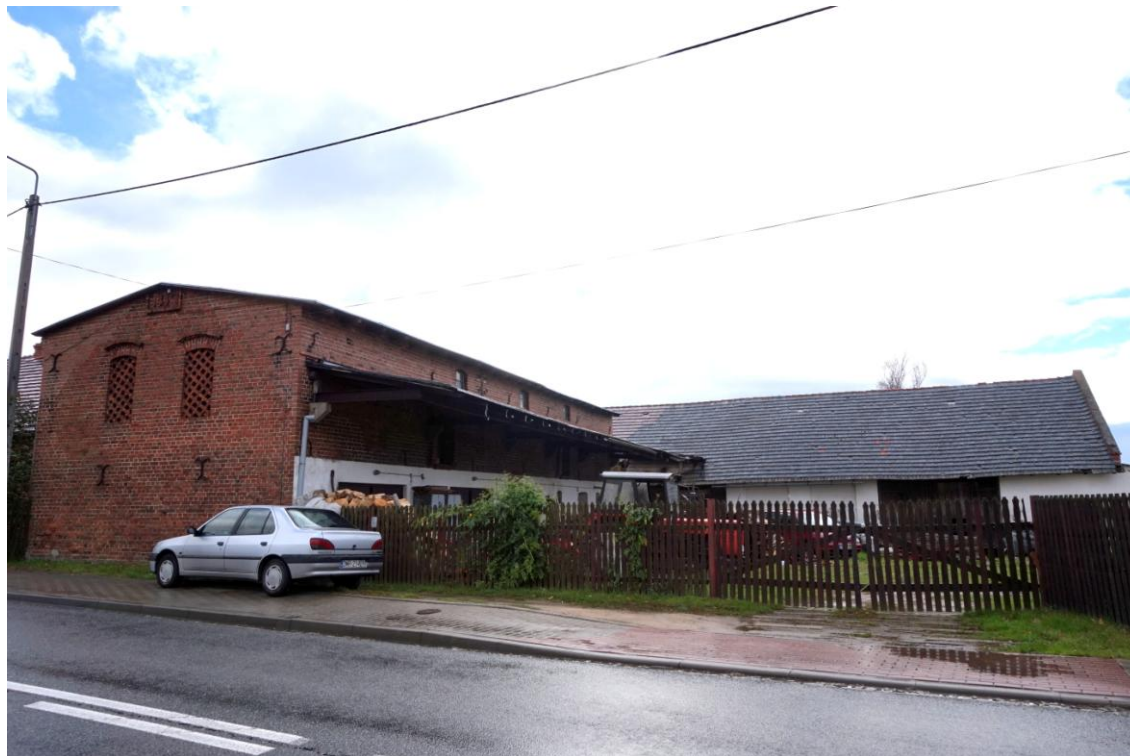
Widok budynków od północy
