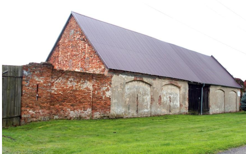
Widok budynku od północnego - wschodu
