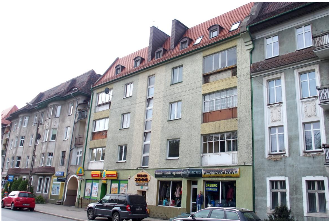
Widok budynku od północnego - wschodu
