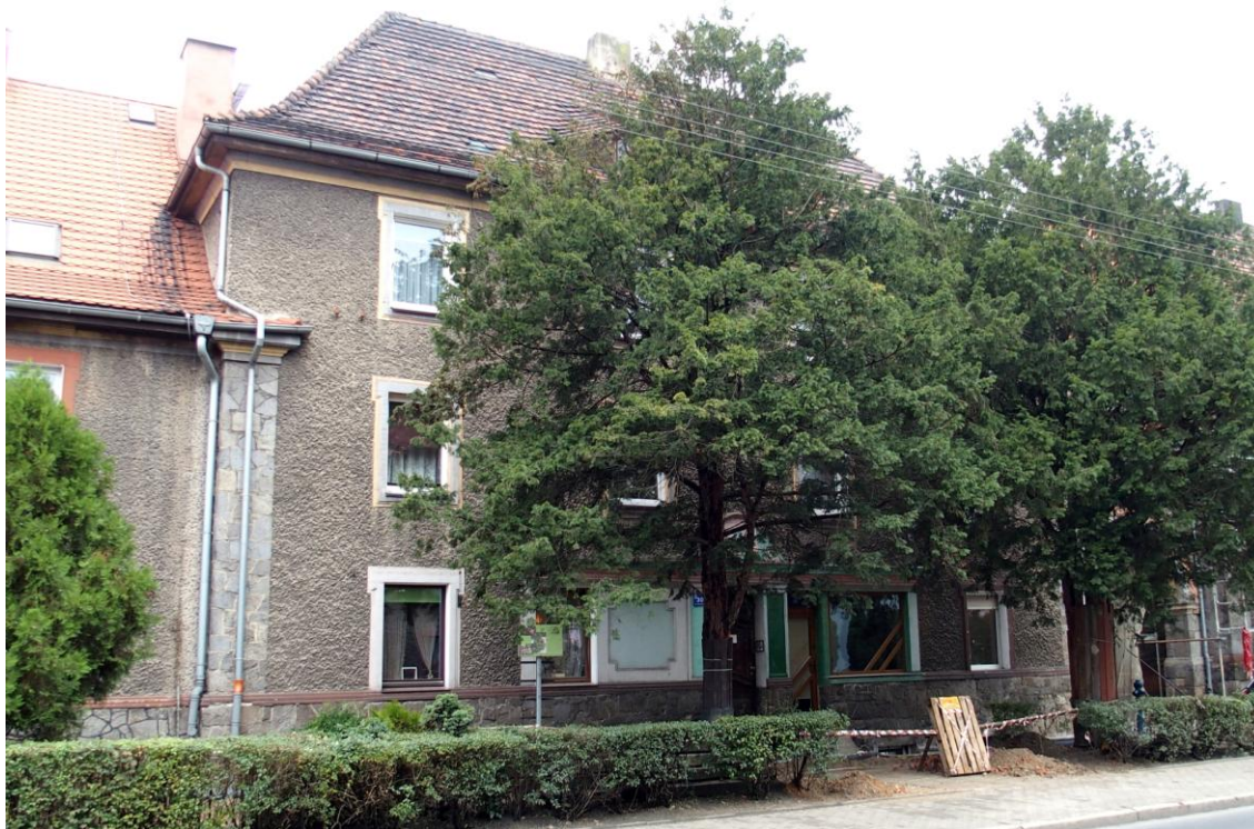
Widok budynku od wschodu
