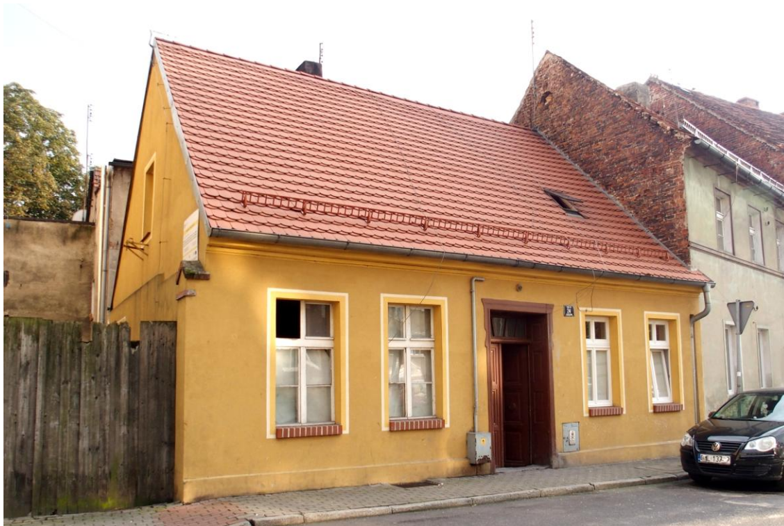
Widok budynku od północnego - wschodu
