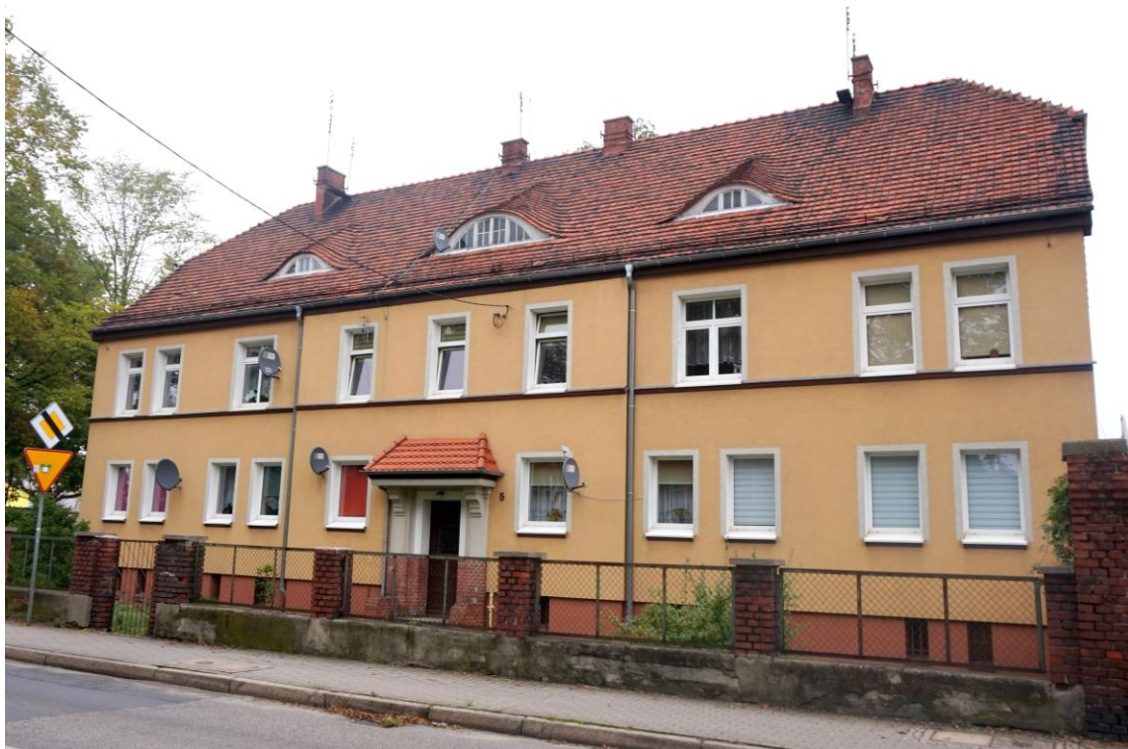
Widok budynku od południowego - zachodu
