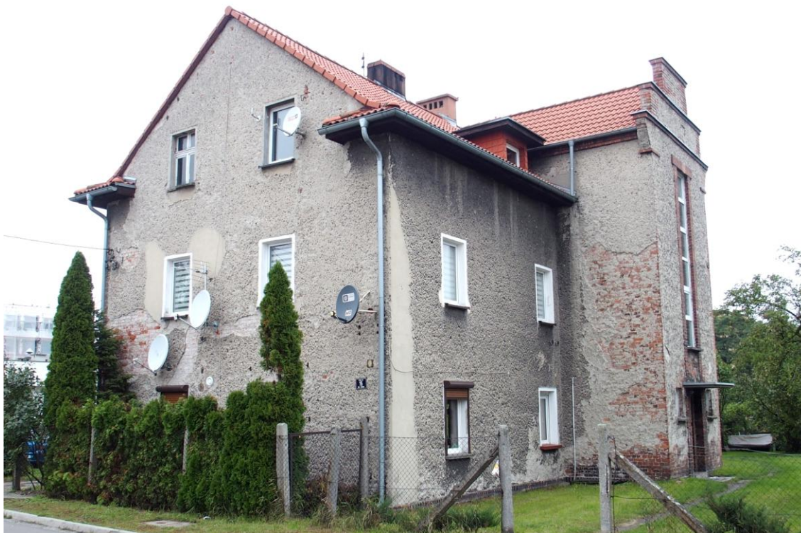
Widok budynku od południowego - wschodu
