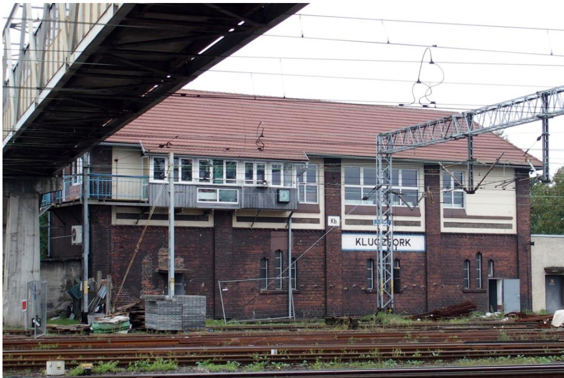
Widok budynku od wschodu
