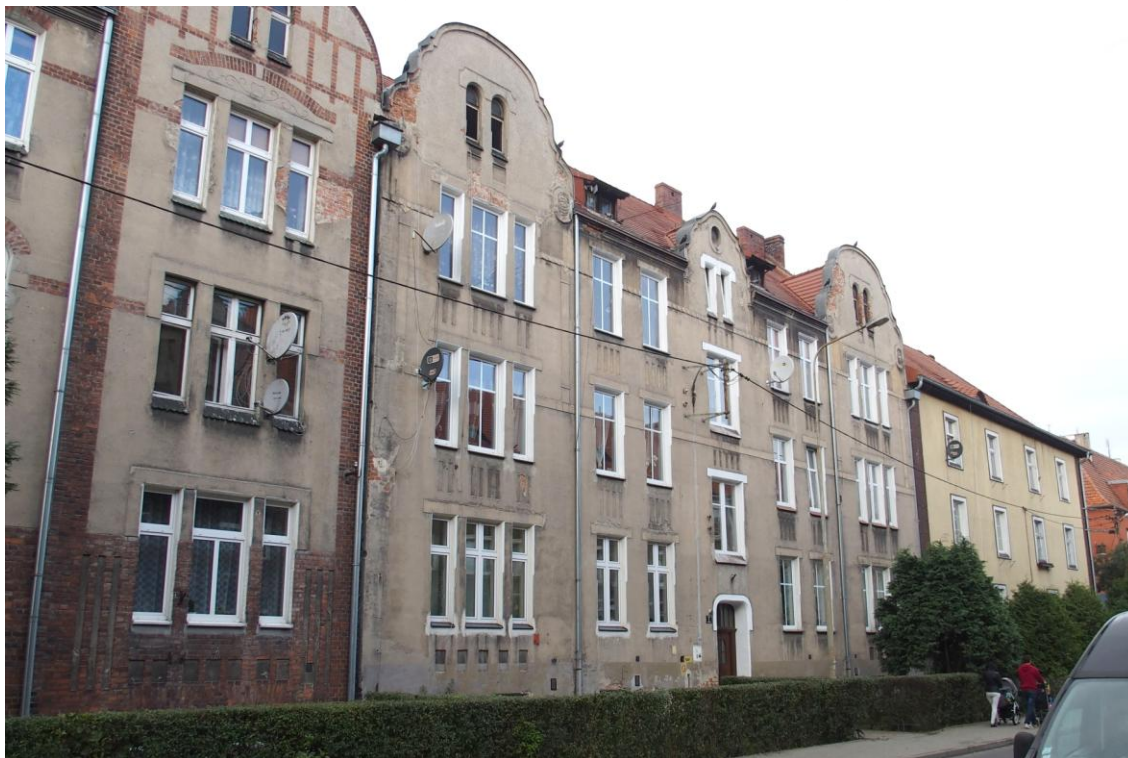
Widok budynku od południowego - wschodu
