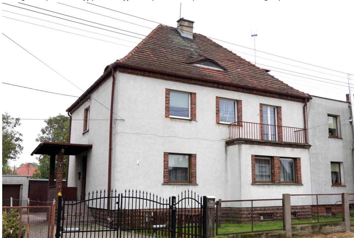
Widok budynku od północnego - zachodu
