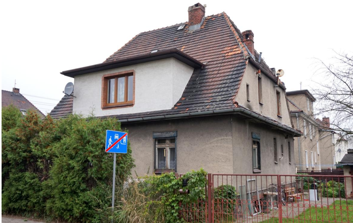
Widok budynku od południowego - zachodu
