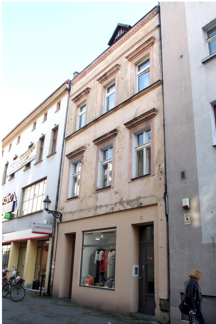
Widok budynku od północnego - zachodu
