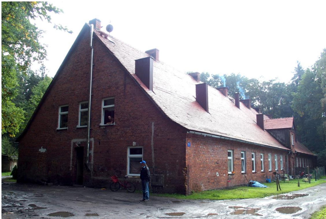
Widok budynku od północy
