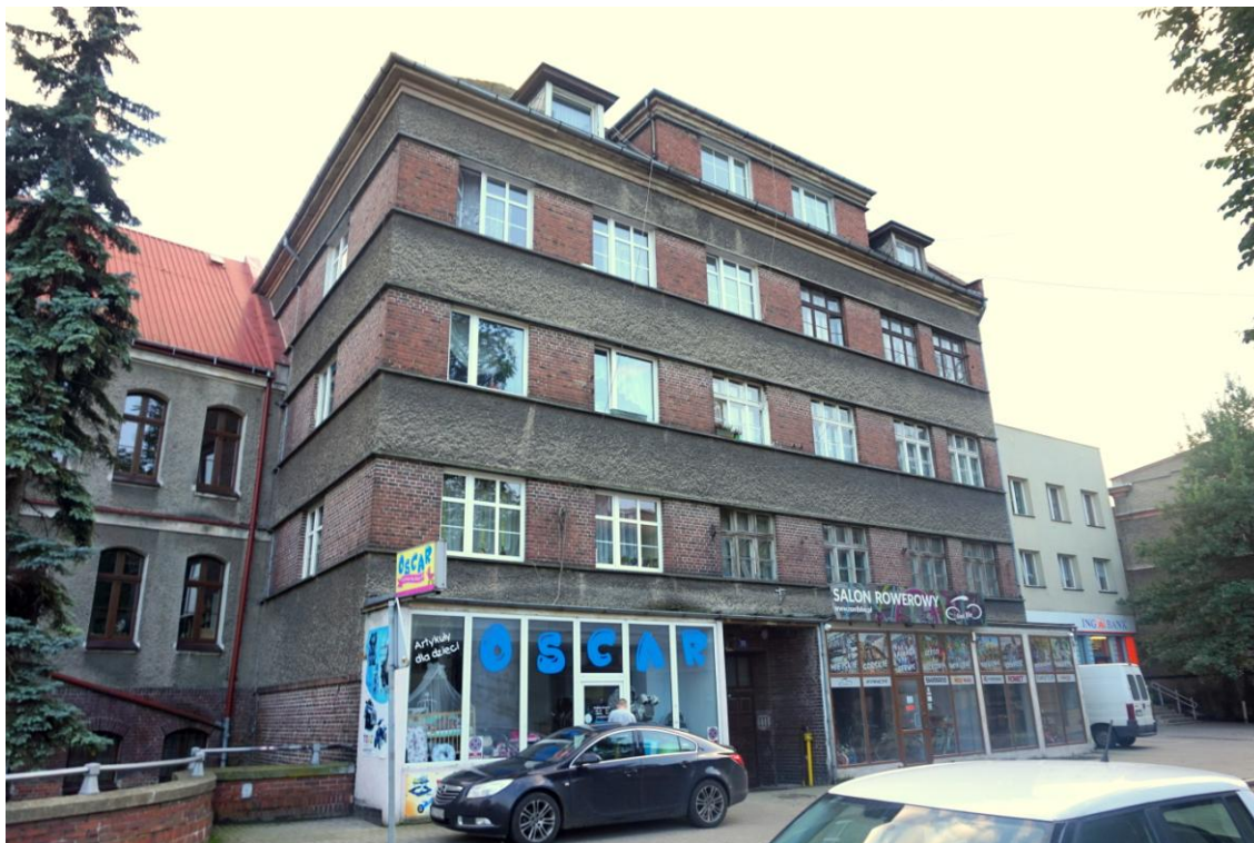
Widok budynku od północy
