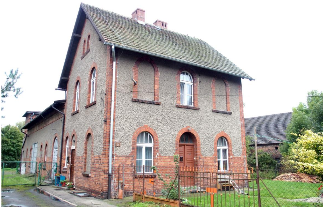
Widok budynku od północnego - wschodu
