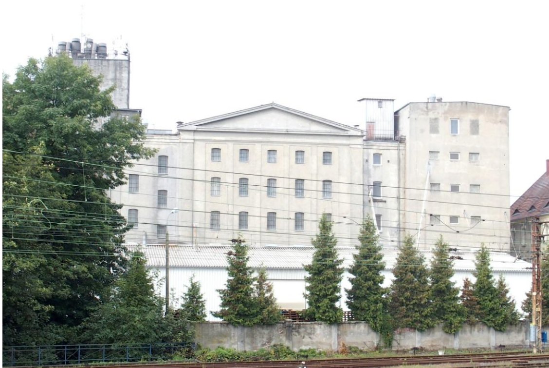
Widok budynku od wschodu
