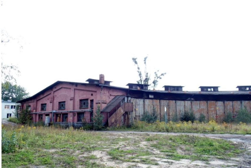
Widok budynku od północy
