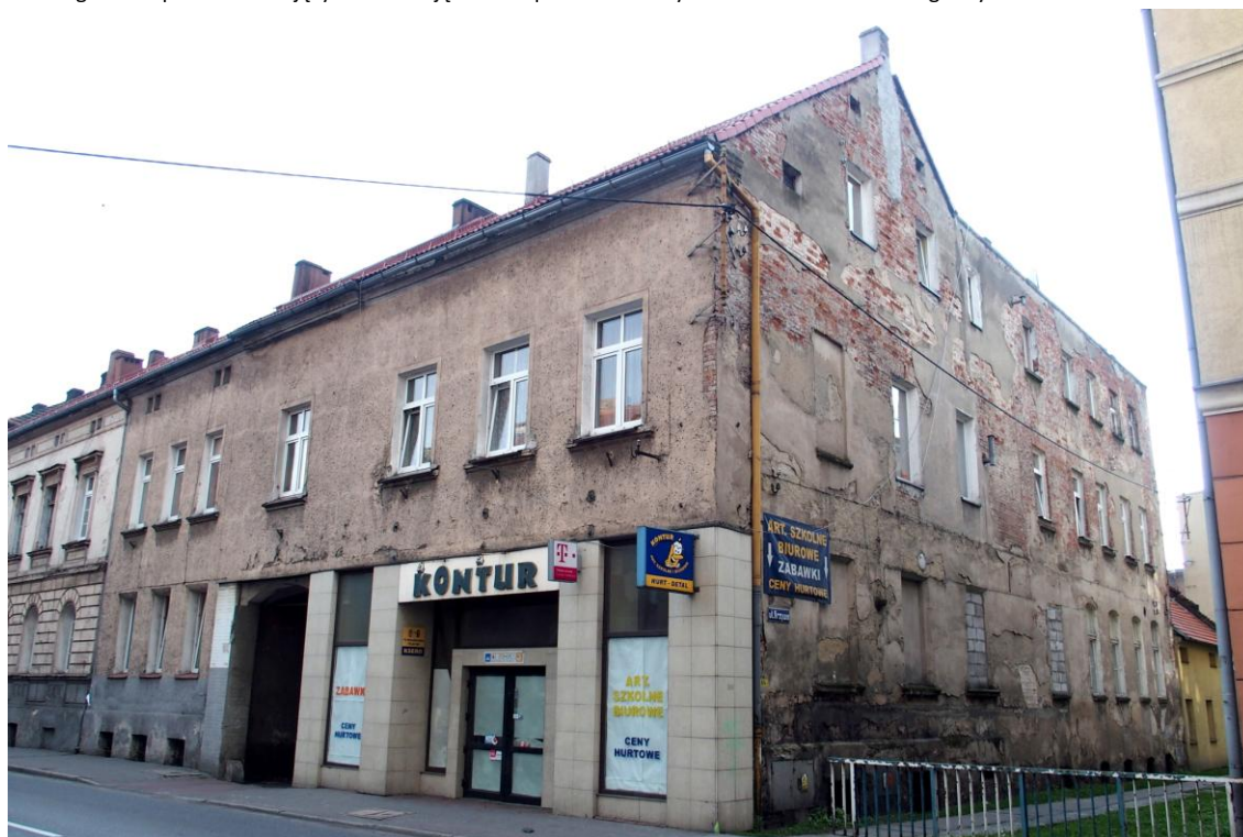
Widok budynku od północnego - wschodu
