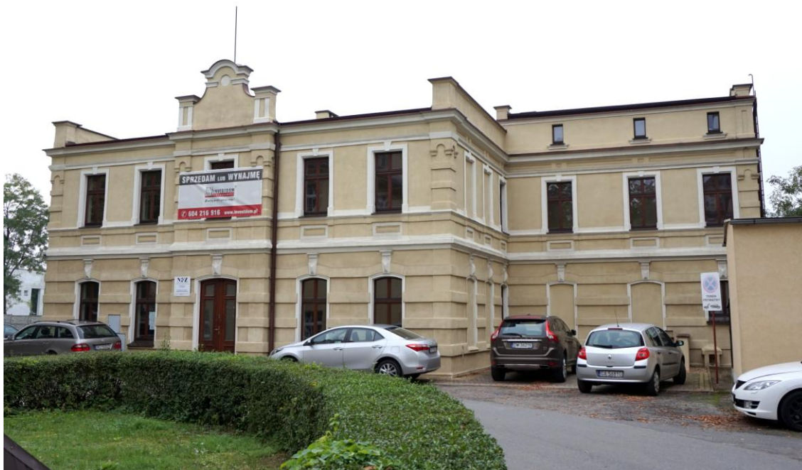
Widok budynku od wschodu
