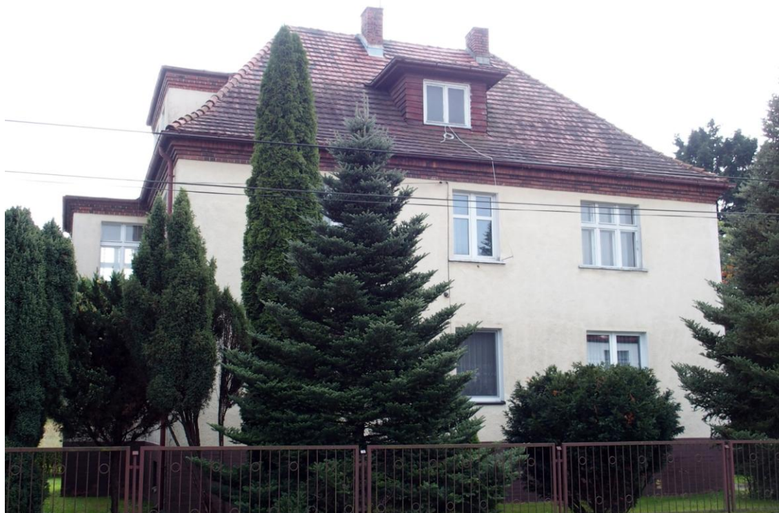
Widok budynku od północy
