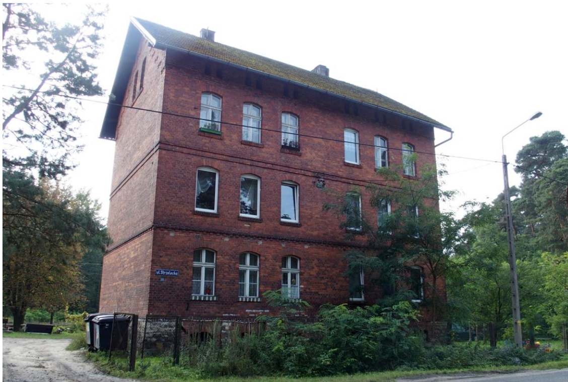
Widok budynku od północnego - wschodu
