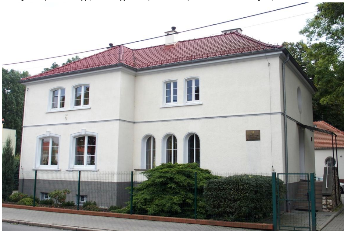
Widok budynku od północy
