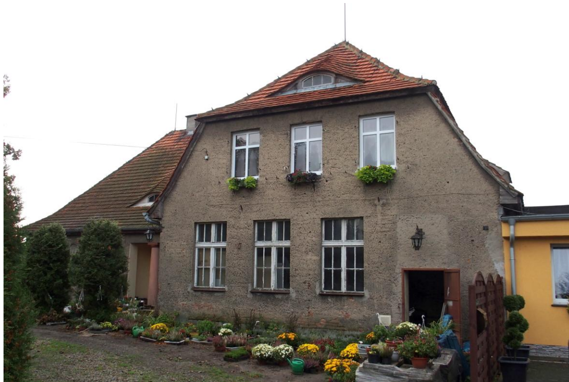
Widok budynku od północy
