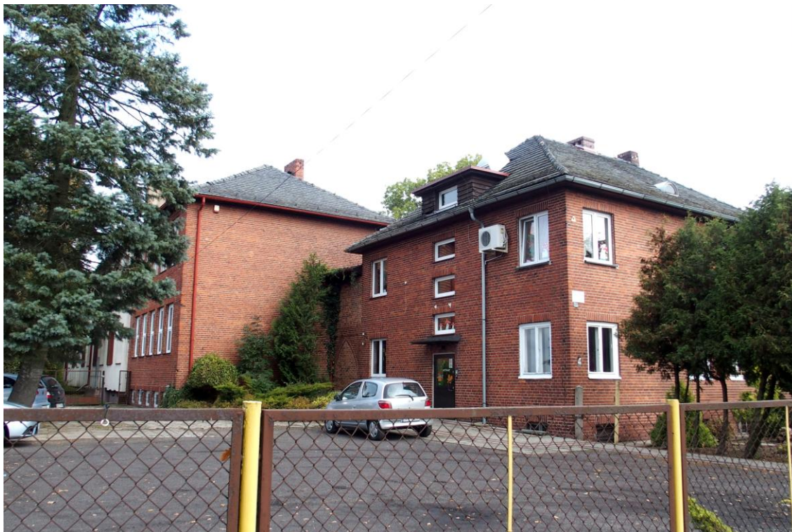
Widok budynku od południowego - zachodu
