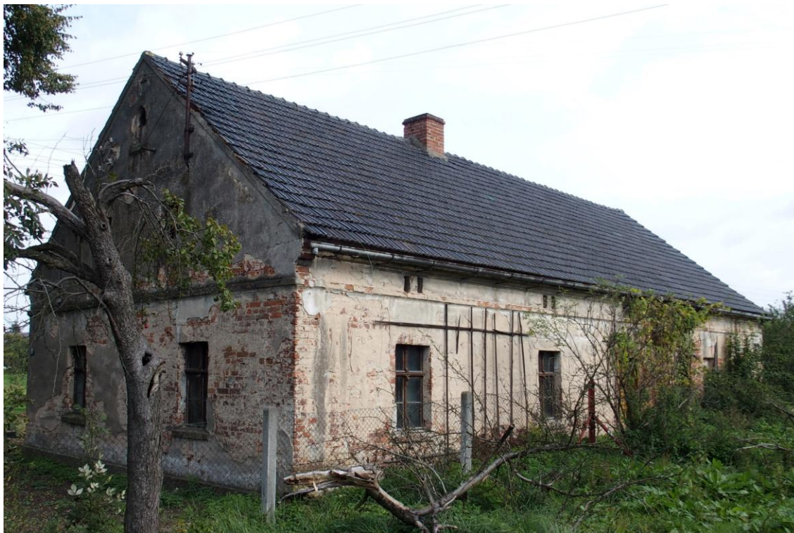
Widok budynku od południowego - zachodu
