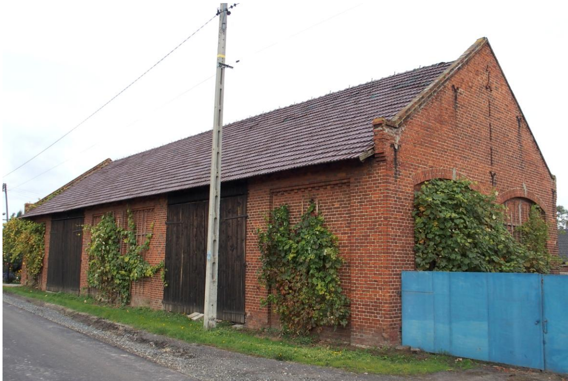
Widok budynku od południa
