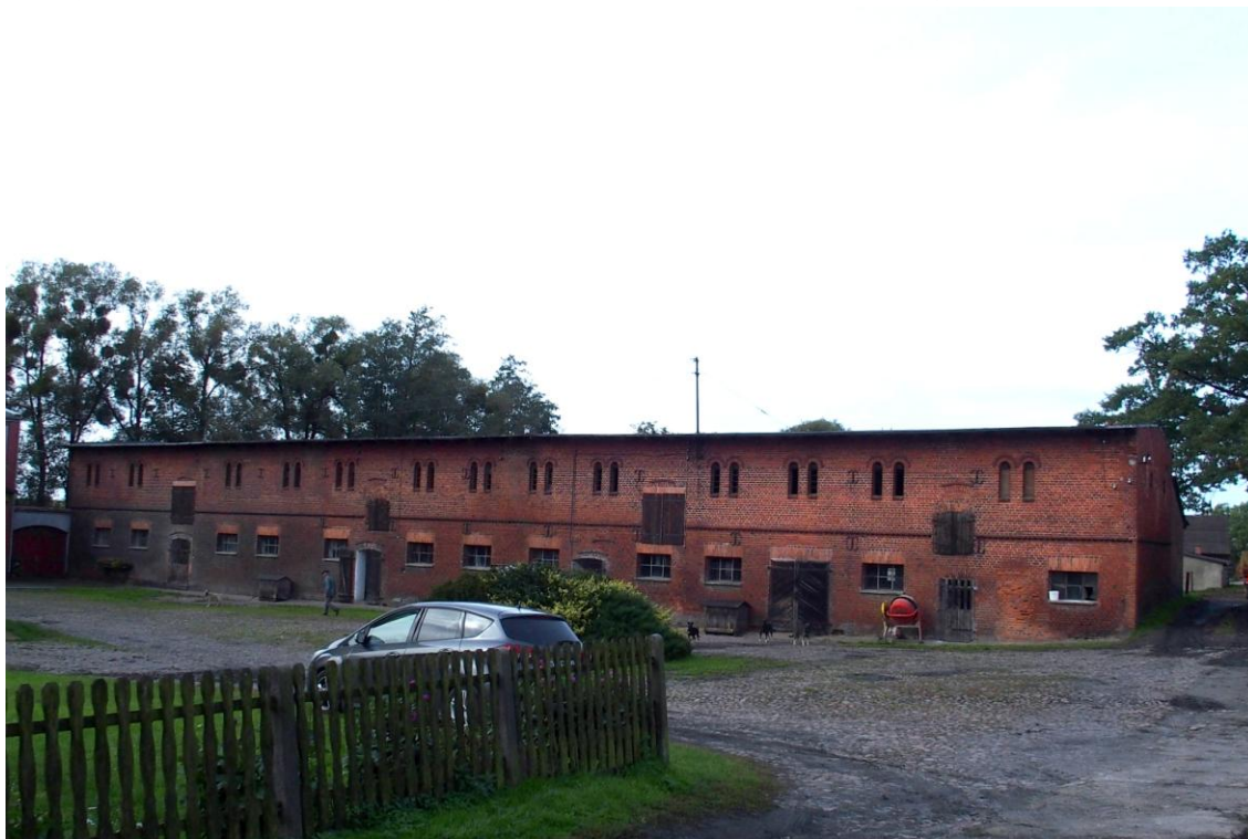
Widok budynku od północnego - wschodu
