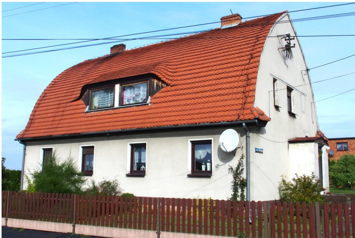
Widok budynku od południa
