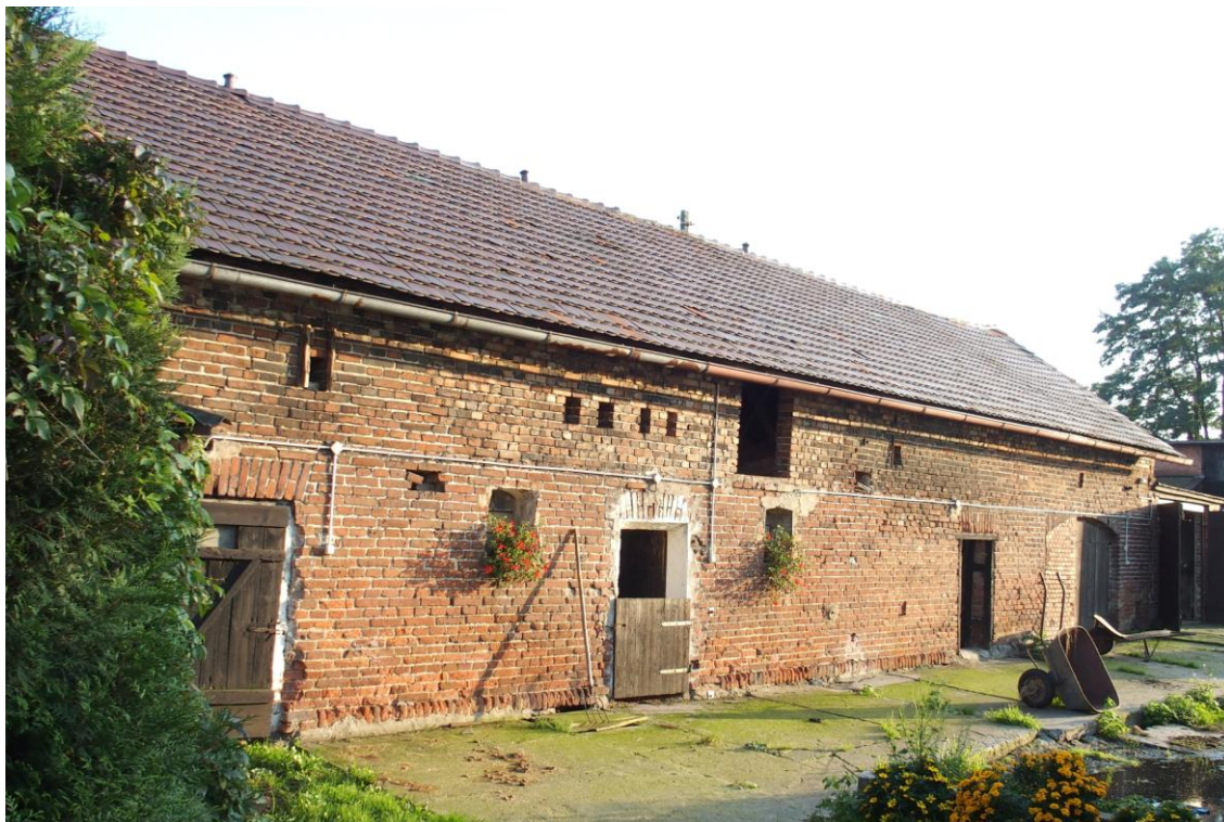
Widok budynku od północy
