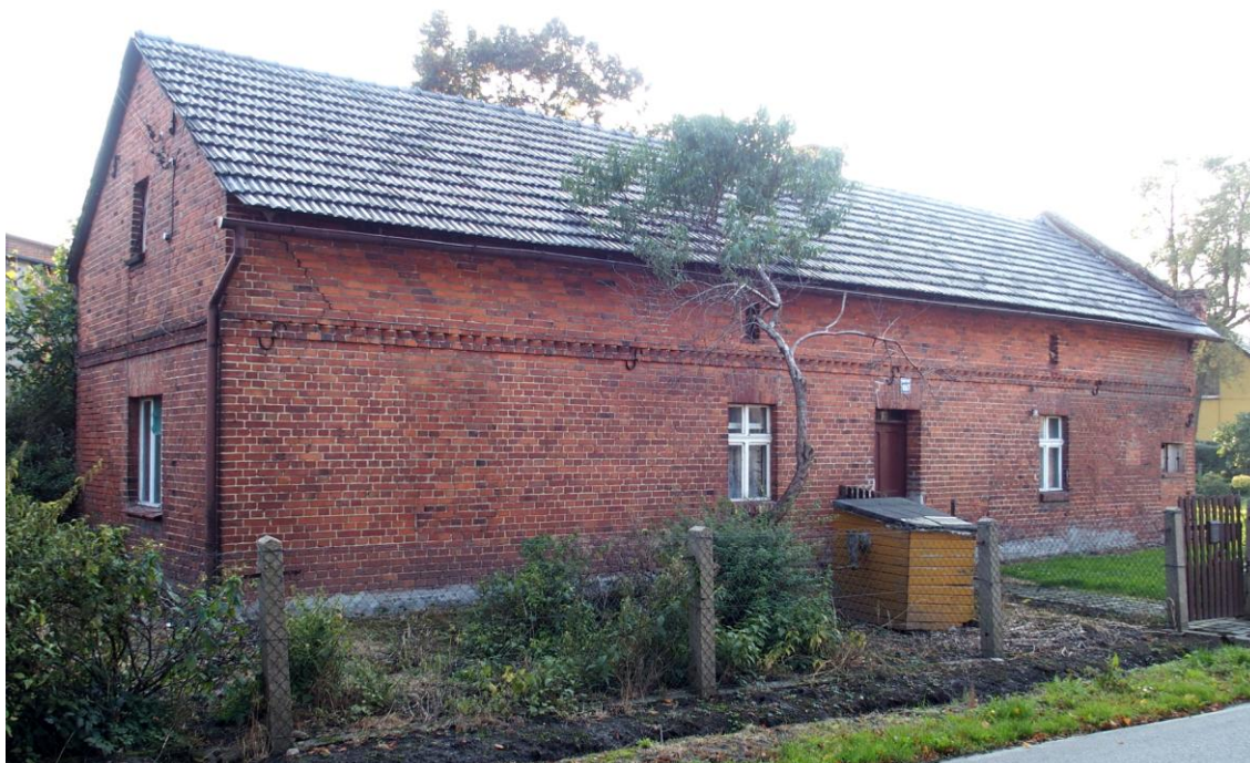
Widok budynku od północy
